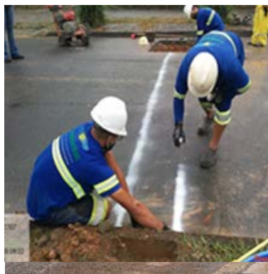
Execução do corte no pavimento asfáltico
