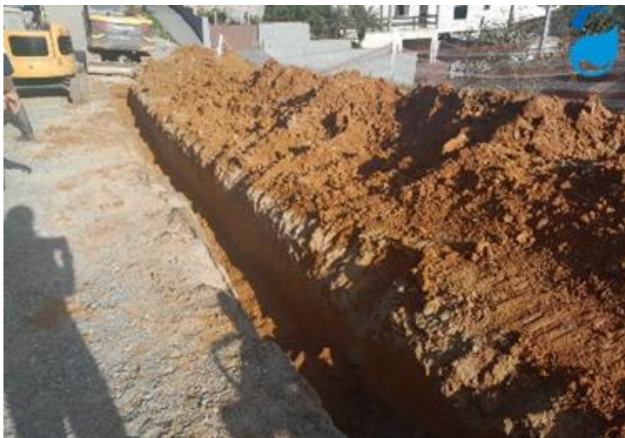
Figura 13 – Reutilização para reaterro de valas
