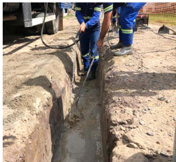
Execução do adensamento hidráulico
