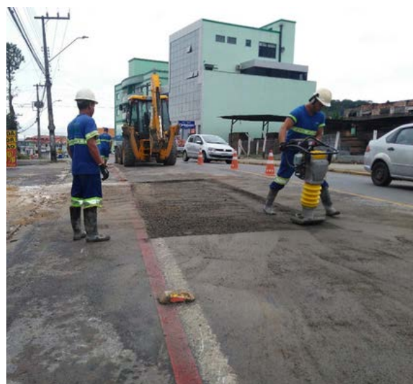
Compactação mecânica (Equipamento a Percussão Tipo Sapo)
