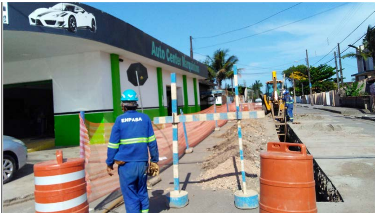
Via sinalizada para execução de obra. Calçada sinalizada e destinada à passagem de pedestres
