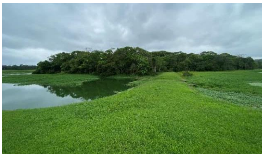
Figura 5 – Vista geral da Lagoa de Maturação M4
