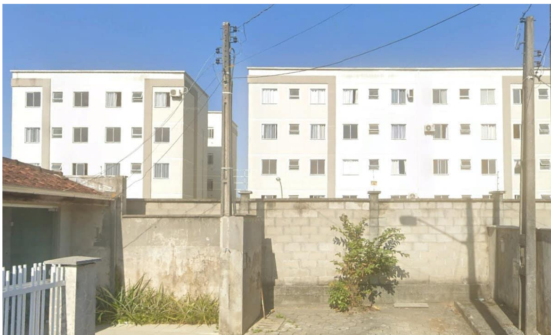
Foto 8 - Vista de apartamentos no Bairro Jarivatuba
