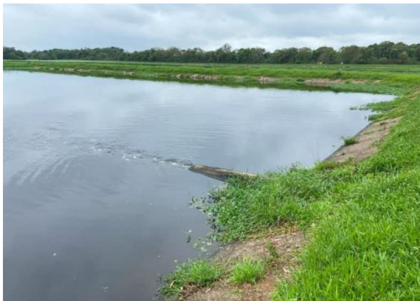
Figura 3 – Chegada do efluente na Lagoa Facultativa F1
