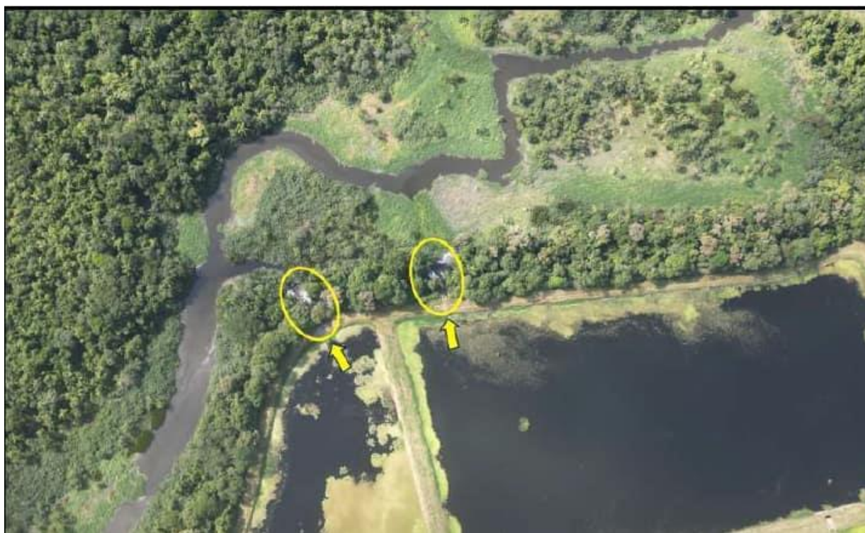
Foto 2 - Pontos de saída dos efluentes tratados nas lagoas de Maturação. Locais onde foram identificadas feições erosivas acentuadas na ADA.
