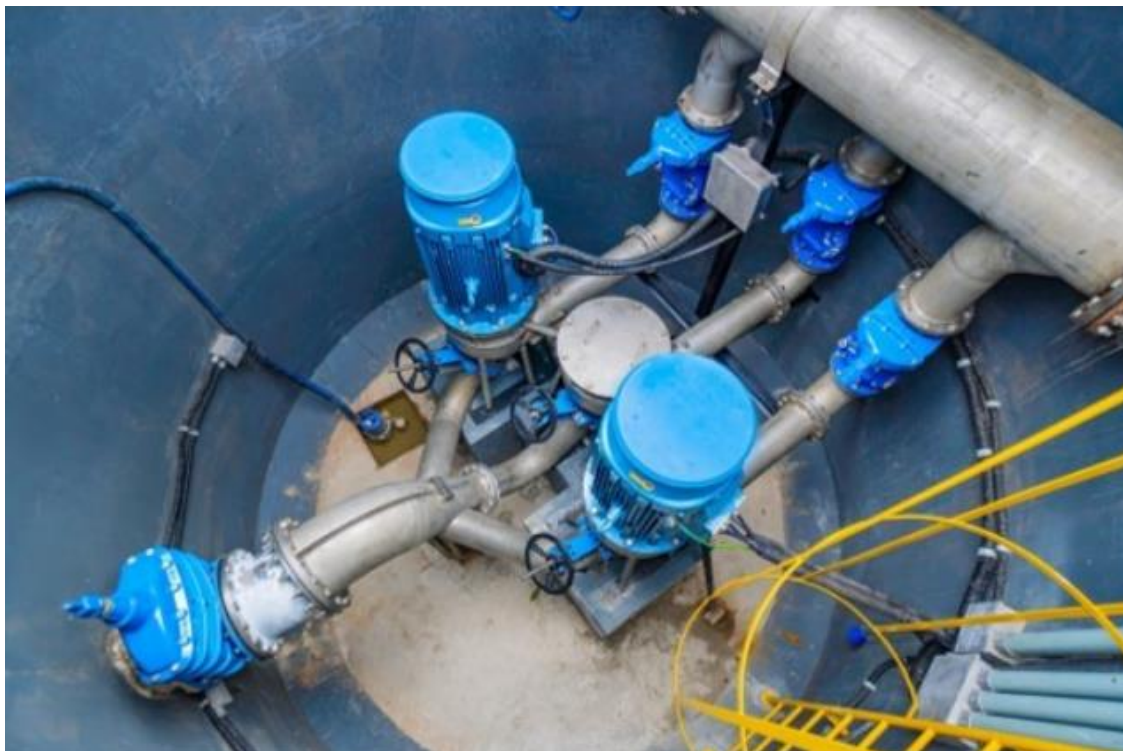
Figura 7 – Poço Seco de um SBL.
