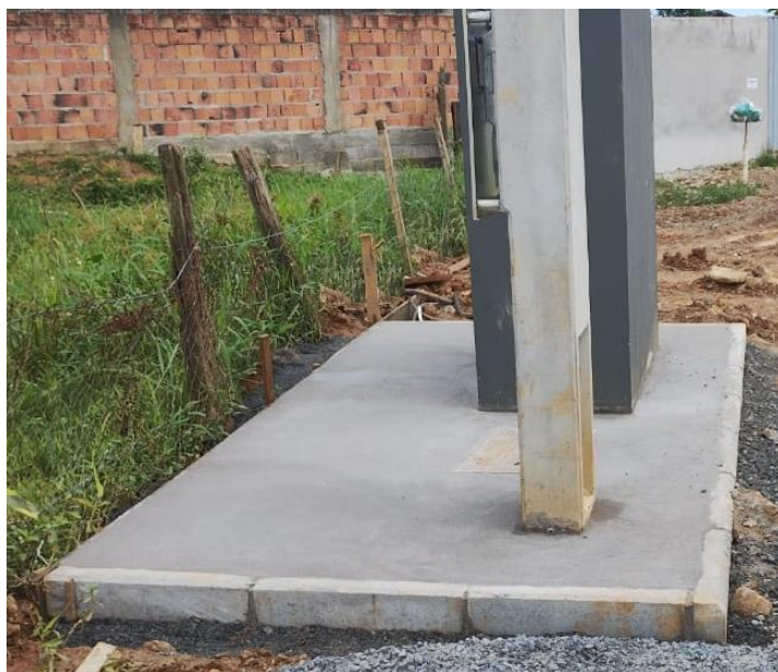
Figura 51 – Demarcação com meio-fio e calçada.
