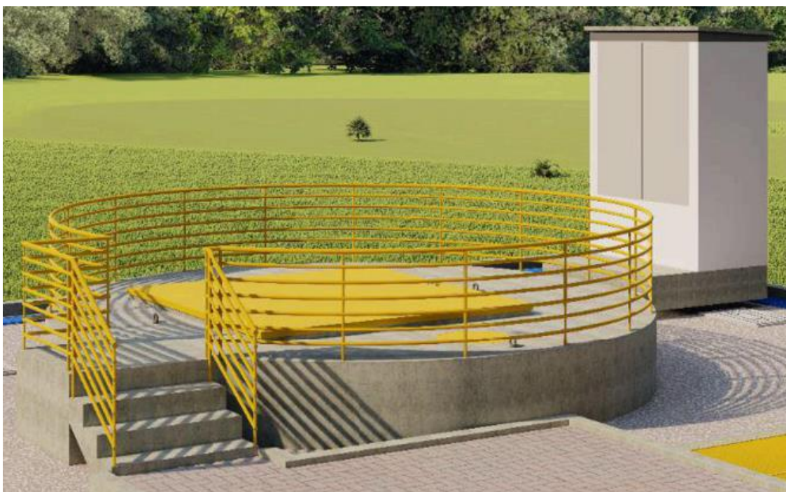
Figura 8 – Abrigo do Painel de Comando e Poço Seco de um SBL.
